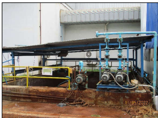
รูปที่ 3-8 บ่อเก็บน้ำเสียจาก Cleansing Caustic Soda
