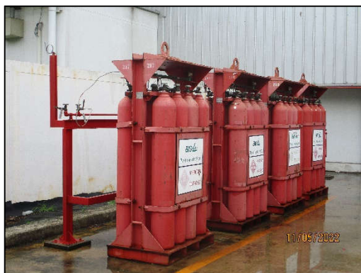
รูปที่ 3-46 การจัดเก็บก๊าซไฮโดรเจนสำรอง
