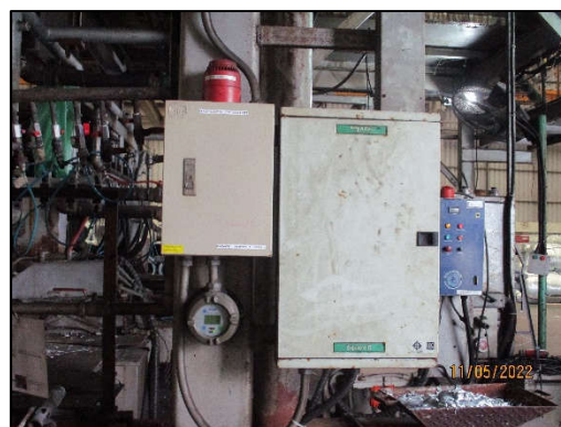
รูปที่ 3-6 การติดตั้ง Hydrogen Gas Detector
