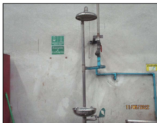
รูปที่ 3-30 อ่างล้างตาและฝักบัวฉุกเฉิน
