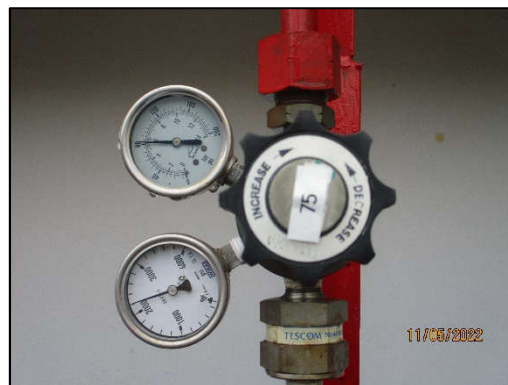
รูปที่ 3-49 ข้อความแสดงทิศทางการหมุนของวาล์วควบคุม ก๊าซและลูกศรแสดงทิศทางการไหลของก๊าซภายในท่อ
