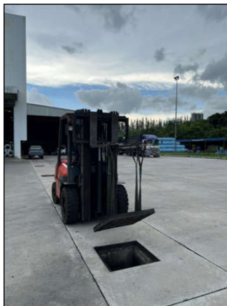
รูปที่ 3-16 การตรวจสอบและทำความสะอาดรางระบายน้ำฝน
