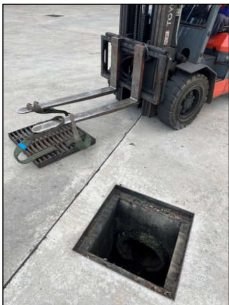
รูปที่ 3-16 การตรวจสอบและทำความสะอาดรางระบายน้ำฝน
