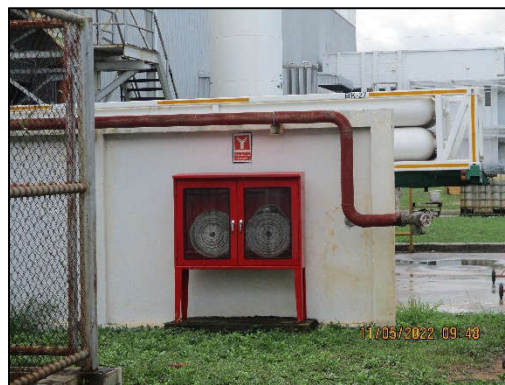
รูปที่ 3-53 ระบบป้องกันและระงับอัคคีภัยภายนอกอาคาร
