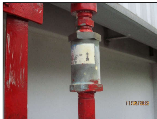
รูปที่ 3-51 อุปกรณ์ป้องกันก๊าซไหลกลับในท่อ (Check Valve)
